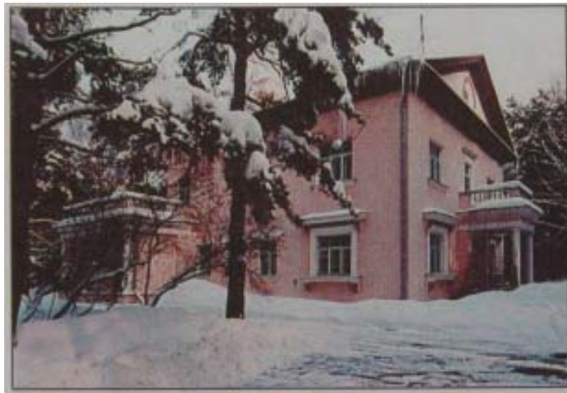
第2研究所の敷地内に、邸宅が建設された。この邸宅に、原子爆弾計画指導者のクルチャトフが住んだ
