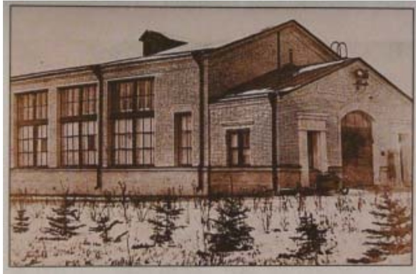
原子炉 - 1 が設置された建家。完成した直後。
