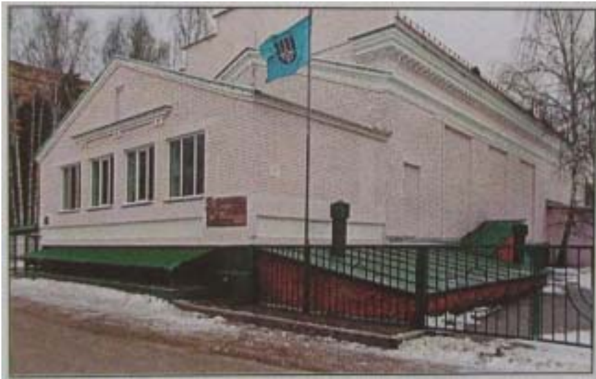
原子炉 - 1 が設置されている建家。現在の姿。
