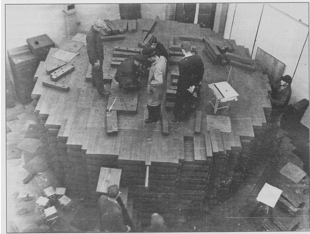
ソ連邦科学アカデミー付属第2研究所の、最初のソ連のウラン-黒鉛型原子炉Φ-1の組み立て中。
