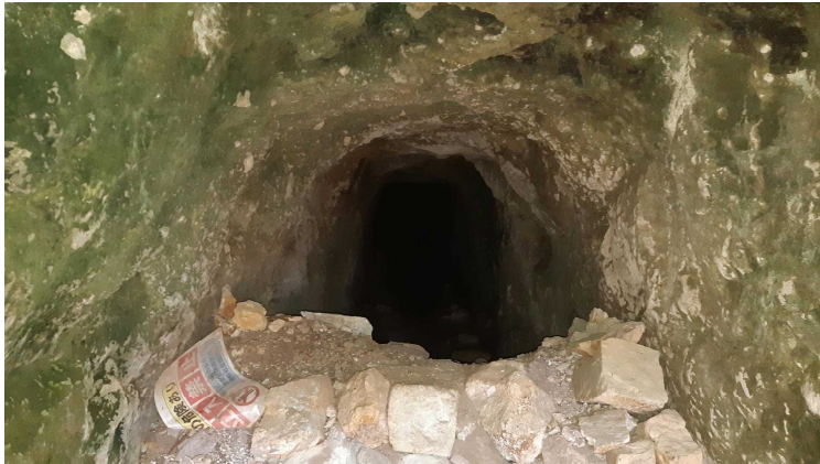
写真１１ 写真１０で示している坑口に接近しての内部の一例。
