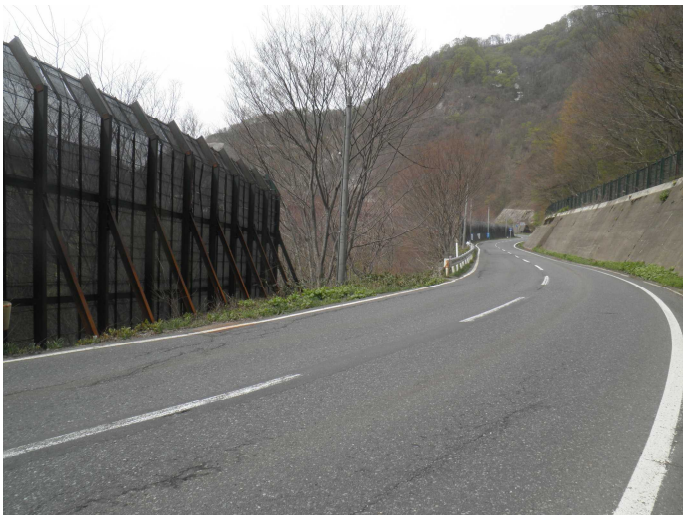
写真1 道路の先は湯田ダムである。日程にダム見学を入れておくのも良い。図2中のA点のところである。前方左側に、防護壁などは無く、和賀川への下り道がある。P点から、このあたりには、山側から崩れ落ちてきた転石が道端に転がっている。良く観察すると、スカルン化した石が多い。少し鉱染している石もある。
