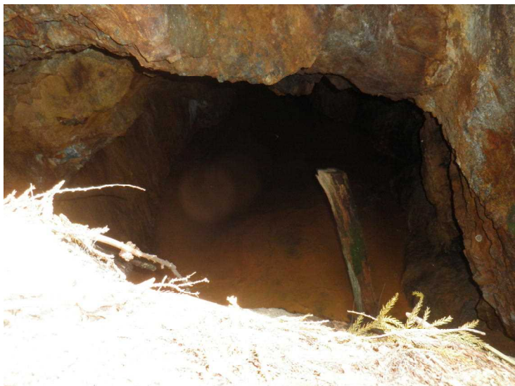
写真5 別の坑口の入口の様子。 入口付近に土砂が積み重なっているため であろう、排水がせき止められて、 内部に溜まっている。
