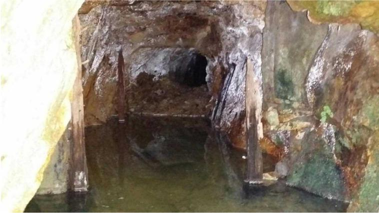
写真7 写真6で示した坑口の内部を入口から撮影。入口付近の土砂を取り除けば、排水できそう。
