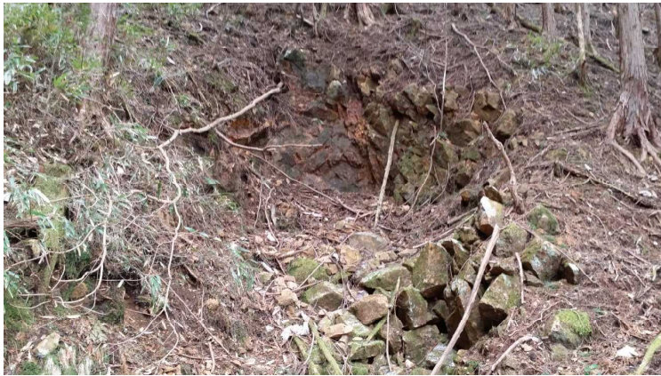
写真6 写真5の坑口跡に向かって、右側の方にあった。潰れた坑口跡。
