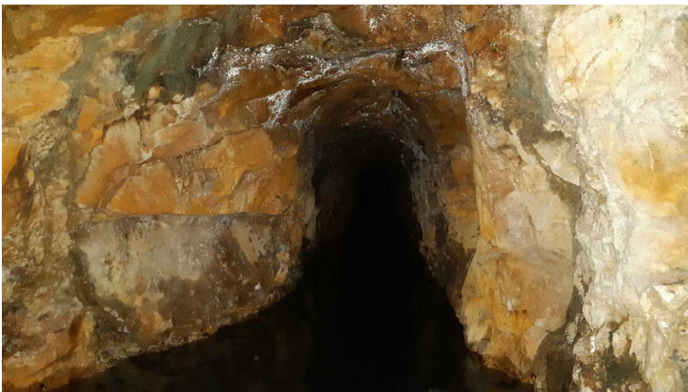
写真 1 2 入口よりカメラを入れて内部を見る。非常に綺麗な坑道である。床に坑内水が貯まっているが、入口の土砂を取り除けば、排水ができそうである。
