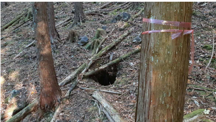
写真 1 8 3 つのうちの中間に位置している坑口跡。中央の黒い部分。坑口というよりは、坑道の陥没でできたものと推断する。
