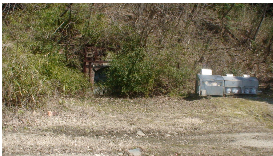
舗装道路脇にある通洞坑
