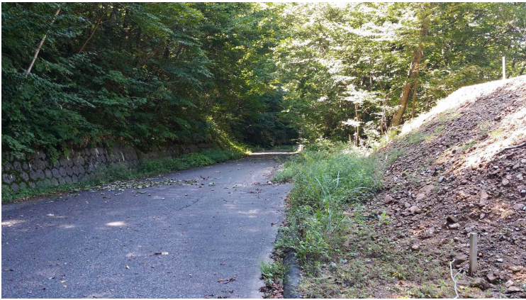
写真 9 P 2点である。何故か谷側に人工の堆積土砂がある。林道は立派な舗装道路である。中央あたりに明るい光の筋がある。ここが、開削された林道入口である。入ってみると、緩やかな斜面である。
