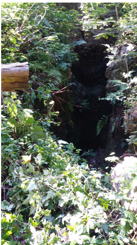
写真14 G点である。古い林道脇にあった坑口跡。坑口の高さは4m～5m。入口付近を刈り払ってからの撮影。草木が茂っている時期には、見失うかも知れない。
