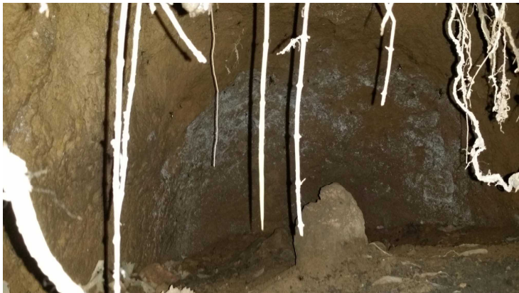
写真 11 写真 10で示した坑口跡にカメラを差し入れて撮影。内部もかなり土砂で埋まっている。
