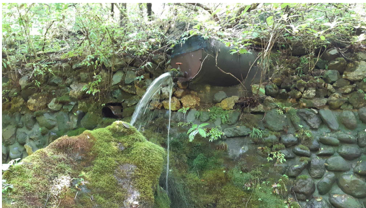
写真3 尚仁沢の右岸のE点にあった配水管。このE点付近は「新通洞坑」の出口の先とほぼ一致している。配水管の先は地中の中に埋もれている。その先には、源流となるべき沢は全くない。鉱山跡地の再開発で、鉱山跡はほぼ抹消されたと思われる。
