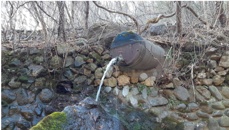
写真7 E点付近で見かけた、排水口。流れ出している水には濁りなどは確認できなかったが、坑道からの排水と思われる。この配水管の先を辿ったが分からず。現地の再開発で完全に埋没してしまったようである。
