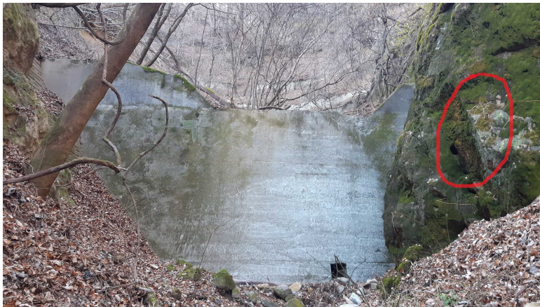
写真3 この沢にあった最終の「砂防ダム」。右側の岩盤には既報の「追記」で紹介しているように垂直な露天掘り跡がある。これを下流側とする。このダムに向かって右端の付け根にも露天掘りの跡がある。写真4参照。上流側とする。これらは岸壁内で貫通しているようである。このダムの上には、少し戻って、沢の右岸を巻けば、容易に登り上がれる。赤丸の岸壁と写真4の赤丸の岸壁は同じ岸壁である。
