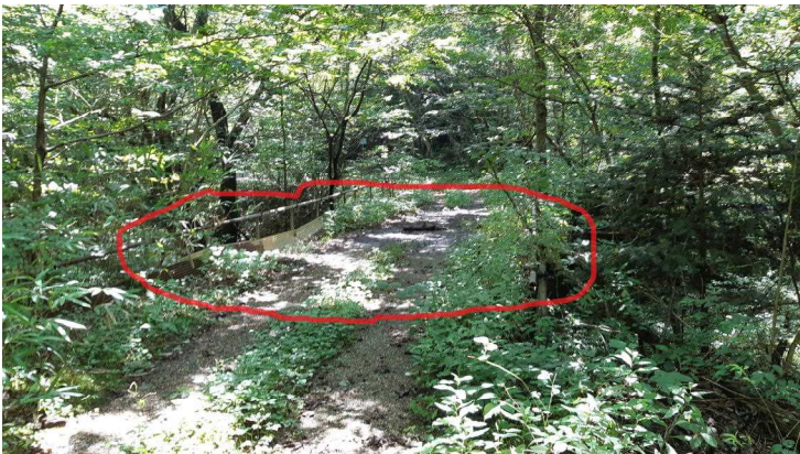
写真5 E点の所。尚仁沢に架かっている「仮橋」のような橋である。赤輪の所。
