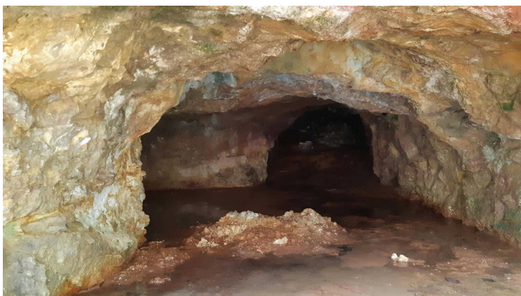
写真 1 1 写真 1 0 で示している坑口の内部の様子。水が溜まっているが、入口に積み重なっている土砂をどければ、排水できるかも。
