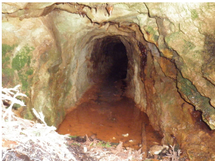
写真5 写真4で示している坑口の内部。非常にきれいに残っている。坑道は西に延びている。直ぐ先に、レールも残っていた。
