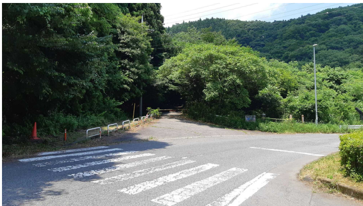
写真2 P1の駐車場から遊歩道の入り口を見ている。
