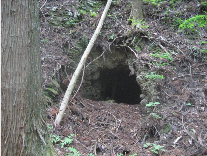
ズリの先にあった坑口跡。
