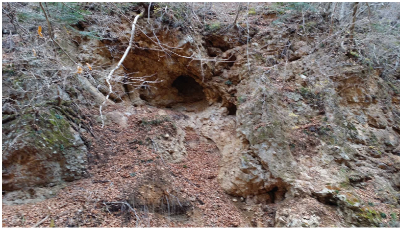
写真5 坑口の一つ。穴が小さいように見える。崩壊した後のようである。
