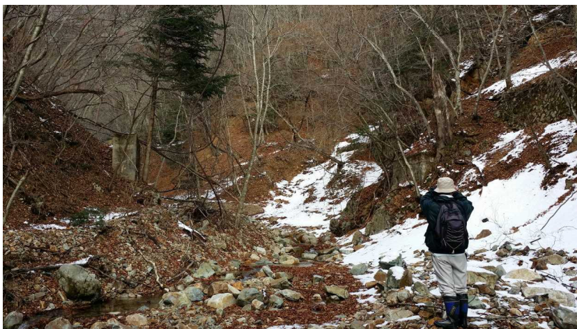
写真1 沢の兩岸に直方体形状のコンクリート製橋脚。左側は、行き止まりであるが、山の斜面は露天掘りされたような様相をしていた。季節外れの降雪で、残雪が白く残っている。
