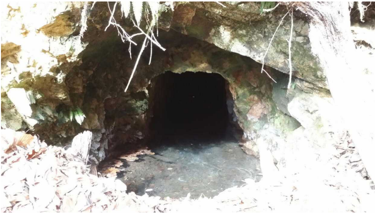
写真3 坑口に近づいての一葉。半分近くまで水没していた。が、坑道はしっかりしていた。スコップなどで、足下の土砂を切れば、排水ができそうであるが、1人、2人では大変そう。
