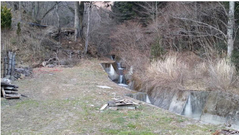
写真8 下りの最終地点である。付近に赤沢温泉がある箒川と赤沢の出会いより、赤沢の上流を見るここから少し上流に最初の砂防ダムがある。次の写真参照。
