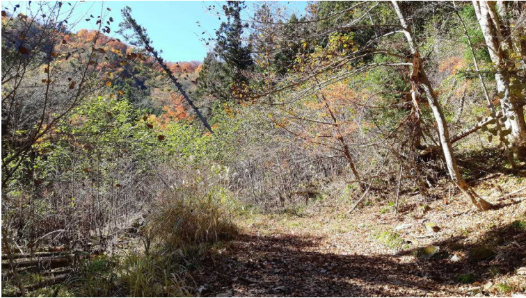
写真1 B点の前方の林道の様子。右側の斜面がなだらかに崩れ落ち林道に覆い被さっている。木々が左側に傾斜しているのが見て取れる。地滑りの跡である。ここから徒歩となる。
