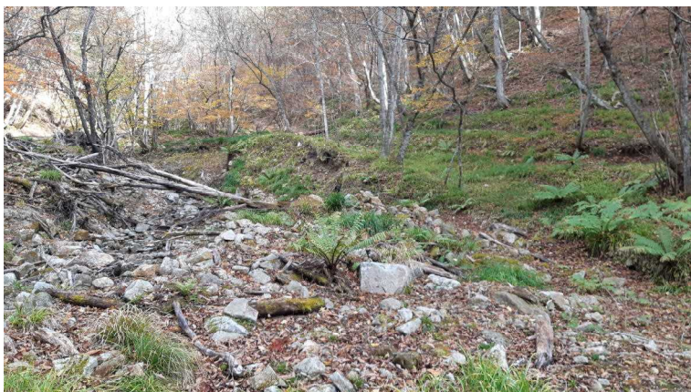
写真8 「銅山沢」の出会いの現状。その2。「銅山沢」の上流からの土石流が橋だけではなく林道も飲み込んでいた。
