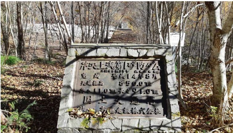
写真3 E点の所の砂防ダム。
