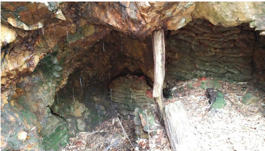
写真12 写真11で示している残雪を少し登り上がって、坑口内部を撮影した。滅多に見たことがない程大きな坑口であった。中心に坑木1本が残っていた。奥一面に岩石入りの土嚢袋を積み上げて、坑道を閉塞していた。
