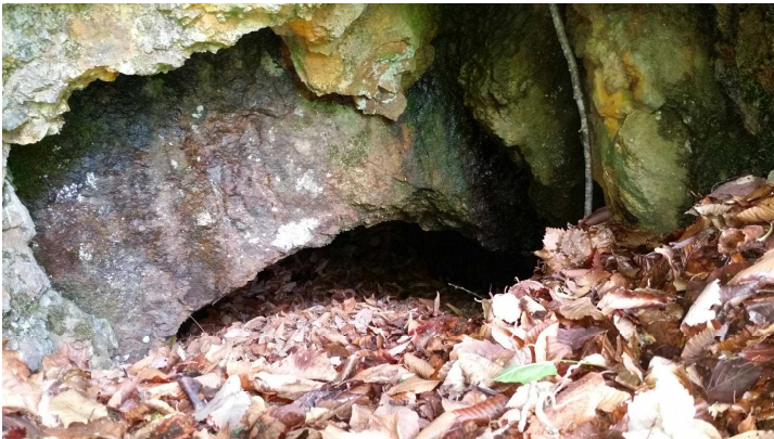
写真7 写真6で示した坑口の近接写真。埋まってしまいそうである。
