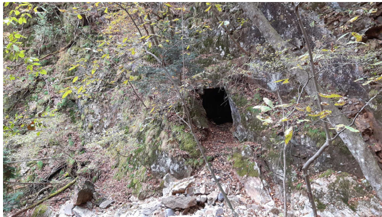
写真6 E点付近の沢の右岸にあった坑口跡。この坑口も鉱山図の3には記載はない。
