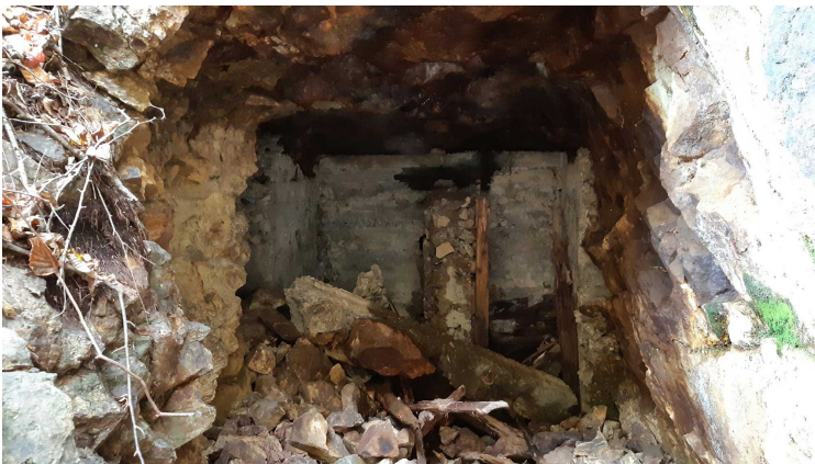
写真7 写真6で示した坑口跡を入口から覗く。コンクリートで確りと閉塞されていた。
