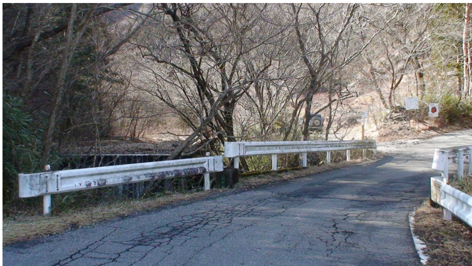
橋の先の左が林道入り口。
