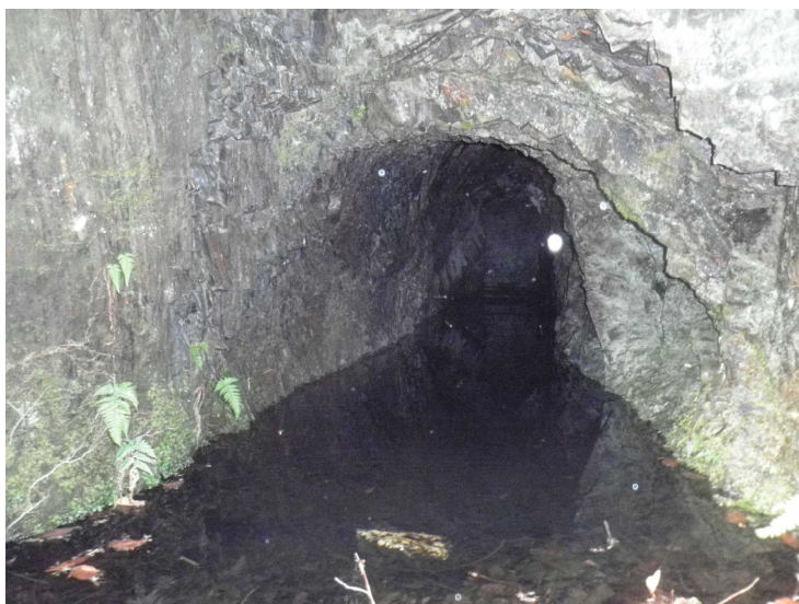
写真4 坑口の1つの内部の様子。 しっかりしている。
