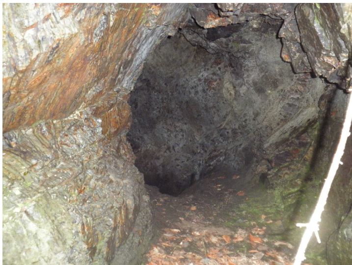
写真5 もう1つの坑口の内部の様子。これもしっかりしている。
