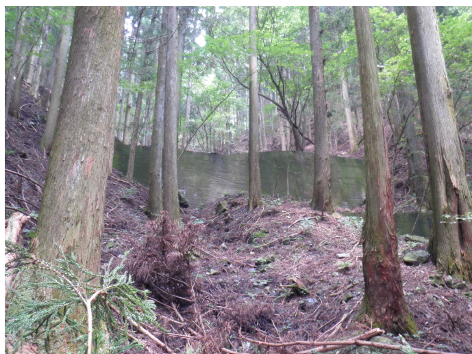
写真2 登って行くと、木立の中の前方に、それほど大きくはない砂防ダムが現れた。このダムの上部にあるズリなどの崩落防止用に設置されたものと思われる。左側で楽に乗り越えができる。
