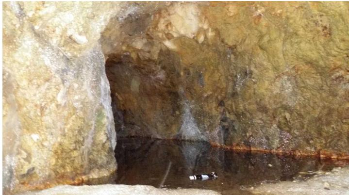
写真6 その内部。壁面は非常に綺麗である。坑底は土砂が堆積し、高さは低くなっている。坑道は左にゆっくりと曲がり、先に続いているようである。このような坑道は前方にある鉱脈への通道坑らしいことを想像させるが。奥には入り込んではいない。
