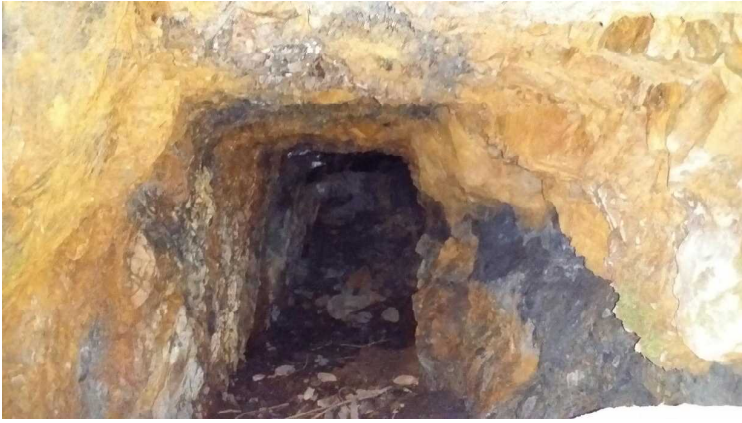
写真7 写真6で示している坑口の内部。水は溜まっていない。
