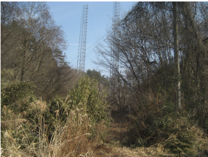
写真6 鮎田鉦山跡は見つけていない。そのあたりには荷重試験のため3基の鉄塔などが設備されている。廃棄されている制御器施設に刻印されている年代は昭和60年（1985年）であった。25年前の建設であった。この施設の建設で消えてしまったのであろうか？
