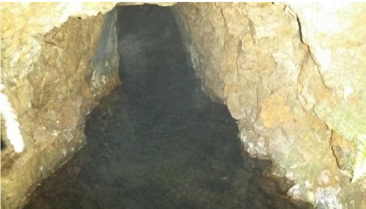
写真4 写真3で示している坑口の内部の様子。坑道はしっかりしている。下部は水没しているが、入口に堆積している土砂を除けば、排水できそう。
