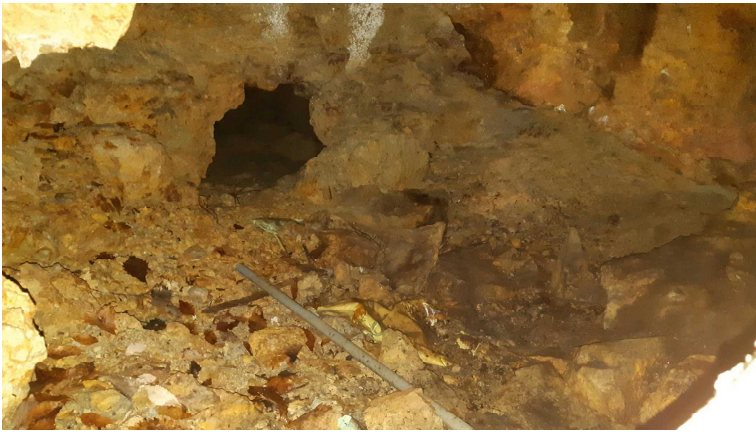
写真5 写真4の坑口跡の内部を、隙間からのぞき込んでの一葉。
