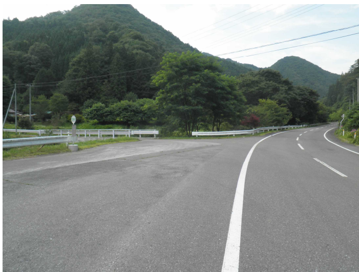
写真1 右側前方に延びているのが主道。左手に奥新切のバス停留所看板がある。周りは広い駐車スペースである。車を留め置きできるかもしれない。左側にある橋を渡り、沢に沿った村道を進めば、現地に行き着く。沢の下流部は、護岸工事が進み、コンクリート沢となっている。
