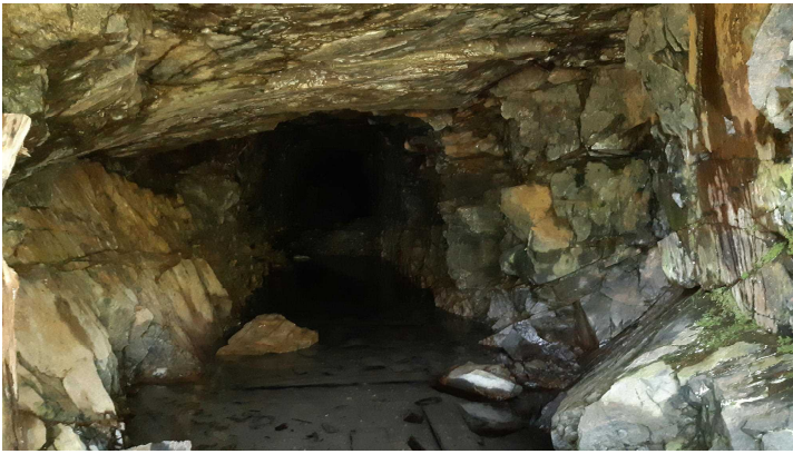
写真9 坑口の中を覗く。下に水が溜まっているが、入口付近の土砂を除けば排水が 出来そうである。
