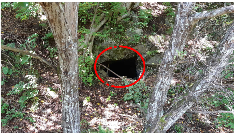
写真8 中央の黒い四角が坑口跡。「通洞」の入口と断定。
