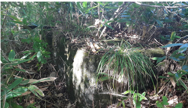
写真11 コンクリートの基台は約5m× 5m。草木に埋もれていたが、少し刈り払 ってのよう。図4に記されている橋の基台 と判断した。とすれば、対岸に同じような 基台があるのかもしれない。が、木々が鬱 蒼と茂っており、対岸はよく見えない。左 岸に渡れば、確認できるかも。次回を期待 しよう。
