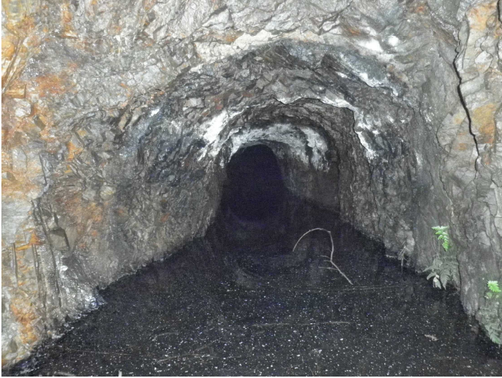
写真13 その内部。底に水がたまっているが、坑道は非常に綺麗であった。
