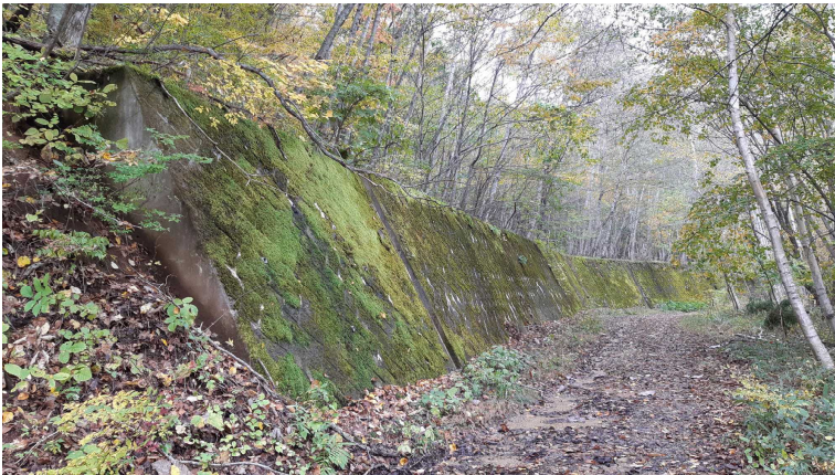
写真1 図1，図2中のC点である。林道を上ってくると、左手にこの擁壁、右下は沢である。河床は茶色をしている。豆知識：この色は上流側に鉄系の鉋床がある証。
