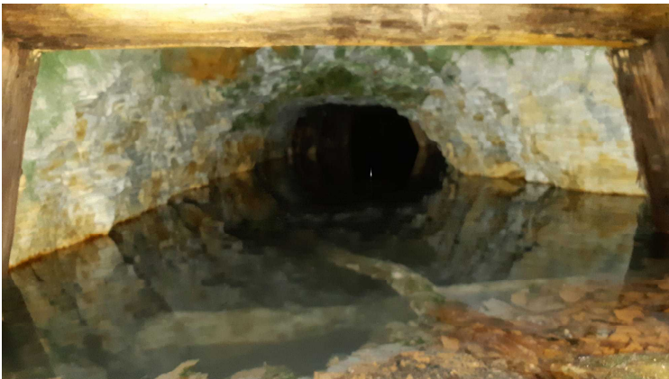
写真3 写真2の坑口から内部を見る。坑道の半分近くが水没している。が坑道はしっかりしている。
