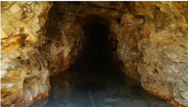
写真 1 5 写真 1 4 の坑口から内部を見た様子。
