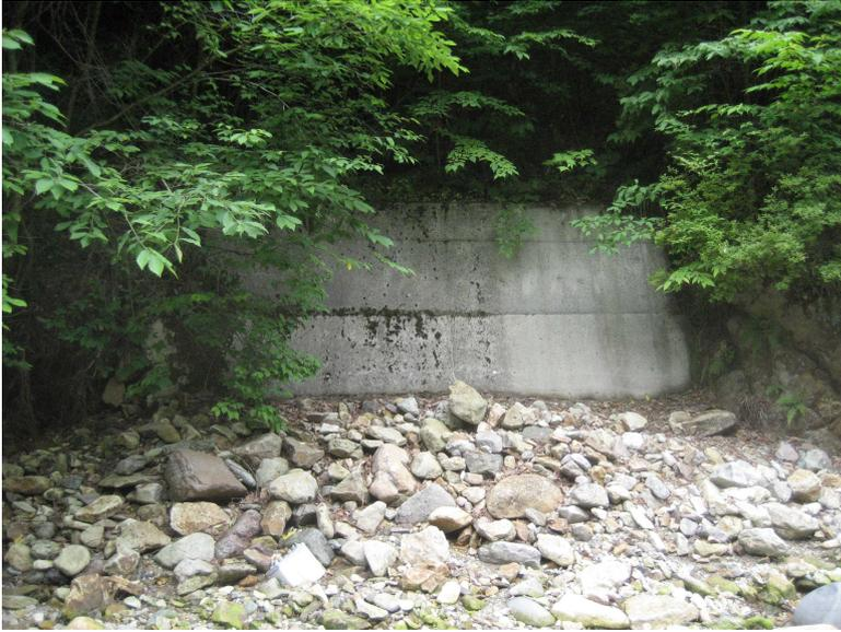
前述の水道橋から少し上流の左側に、沢に接してコンクリートの壁があった。坑口を塞いだ跡と思う。この左側には、坑内からの流出水に夜ものであろう。一面茶褐色となっている石垣組の箇所がある。
