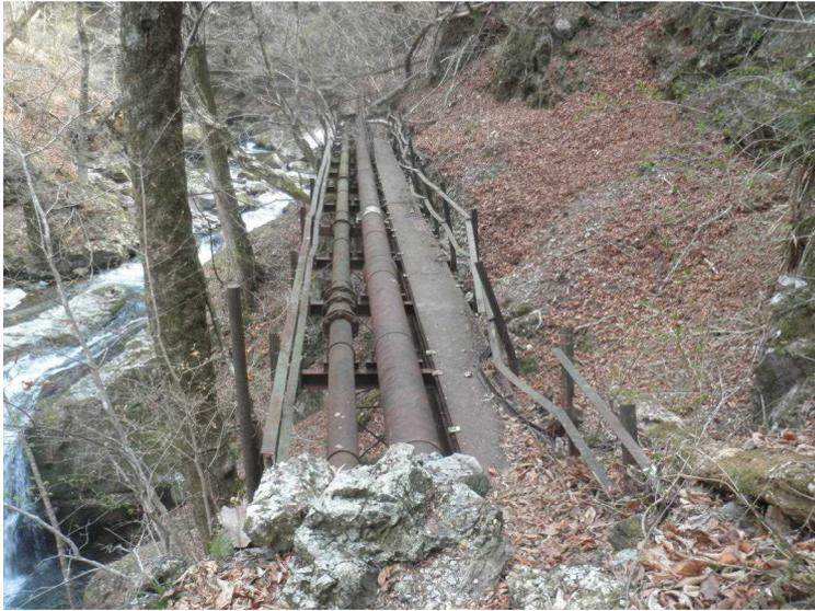
写真8 水道管が沢を渡っている箇所の様子。歩道がしっかりと設置され、手すりまで着いている。構造はまだまだしっかりしている。用水道跡は歩きやすい。
