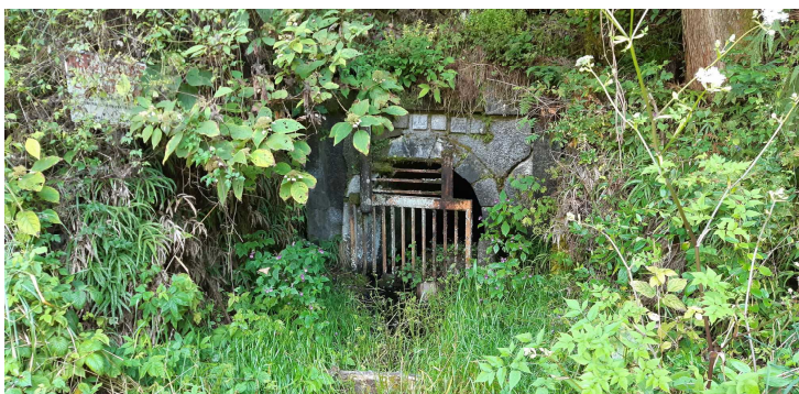
写真7 A点の「大通洞坑」跡である。
