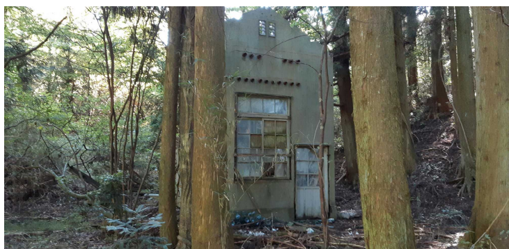
写真20 荒井川の南側(右岸)、図6中のC点にあった「発電所」らしかった建物跡。建物の4面の内の2面だけが立ち残っていた。上部の沢山の貫通穴、地面に落ちていた多数の磚子から、ここに発電機があったと推論した。
