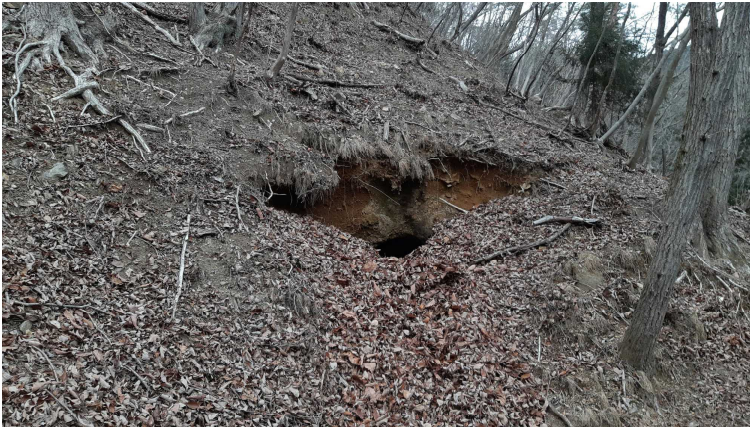
写真5 写真4で示した左側の赤輪に近接しての一葉。落ち葉で坑口前が埋められている。完全に埋められるのはそれほど先のことではなさそうである。
