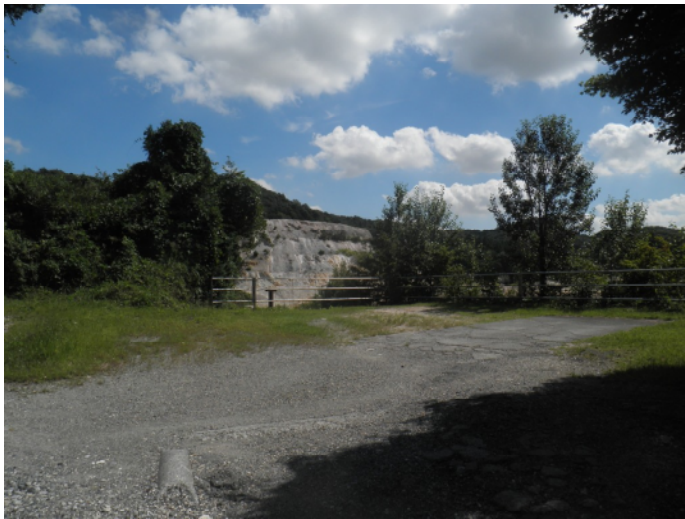
写真2 休日に訪問した。写真1の所から200m～300mほど緩やかな道路を上りきると、展望台があり、ここから露天掘り現場を見学することができる。
