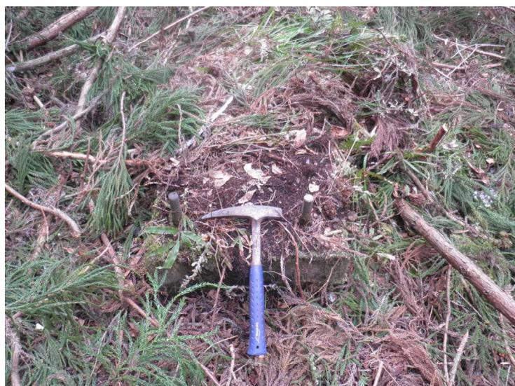
写真4 石垣組の上部は少し開けた場所となっていた。真ん中あたりに、ボルトの立っているコンクリート基台があった。2本のボルトはハンマーの頭の両側。鉱山施設で機械の固定用に良く用いられている形である。周り一帯にマンガン鉱の転石が落ちている。
