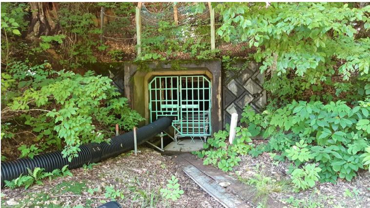
写真13 P点である。立派に管理されている坑口跡。坑内湧水の排水用であろう太いパイプが施設されている。
