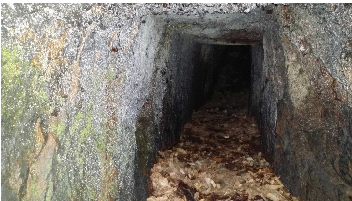
写真8 写真7で示した坑口の内部の様子。坑道は長方形に開削され、水平に延び、かつ、しっかりしている。先にある鉱脈への通道坑としたものであろうか？
