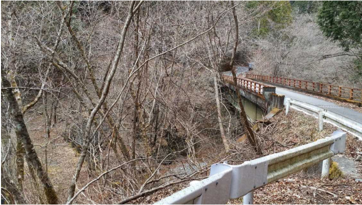
写真5 蕨橋である。橋の下流をよく見ると、旧蕨橋が残存していた。このあたりから東大芦川の河床に降りる。
