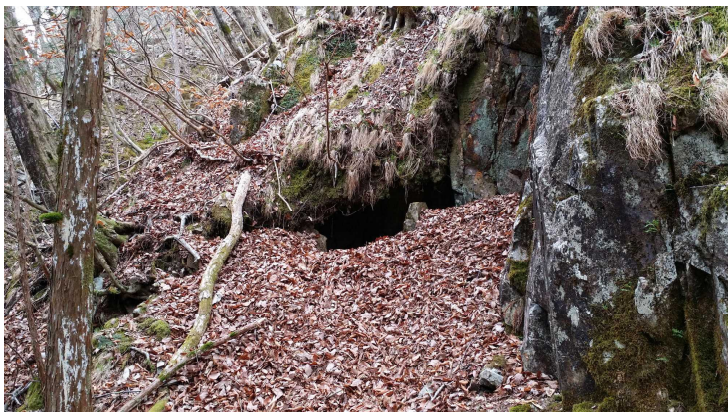
写真 12 写真 9 で示した坑口跡の少し右上にあった坑口跡。中央の黒い部分。
