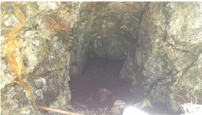
写真3 坑口入口付近の様子。水没している。
