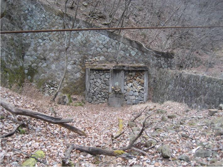
沢で最初に遭遇した坑口跡。沢の右岸にある。しっかりと密閉されている。上部左右に伸びているワイヤーロープは地形図2中の赤丸の所まで伸びている。
