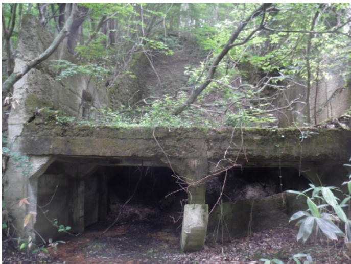
写真2 ゲートから歩いて500m程。右手の先にあったコンクリートの残骸である。形状からすると、鉱石のホッパー施設のようなものである。ここの右側を登り切れば、1番目のズリ跡にでられる。
