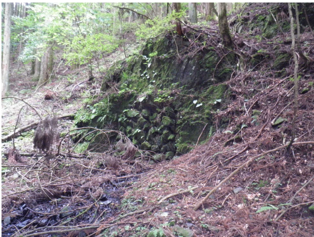
写真6 駐車場から橋を渡り左側の沢に入っていく。途中、右側の大きな支流沢の少し上流にあった坑口跡。中央が坑口跡。苔むした岸壁の真ん中が、石組みでしっかりと閉塞されている。が、坑内水が少しづつ流れ出している。一体にズリがある。ここから、画面左手上流に、施設跡らしいプラトーがある。その先には、落差の大きい滝があり、行き止まり。
