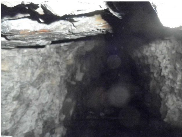
写真7 石垣の上部の隙間から撮影した、閉塞された坑口の内部の様子。
