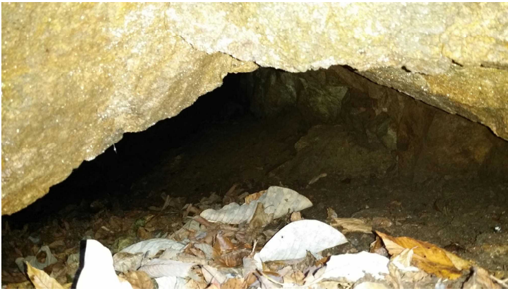
写真7 写真6で示した坑口に、カメラを差し入れて内部を撮影。入り口付近は上部から落下してきたであろう土砂が堆積している。が、奥は深く、坑道はしっかりしていそう。
