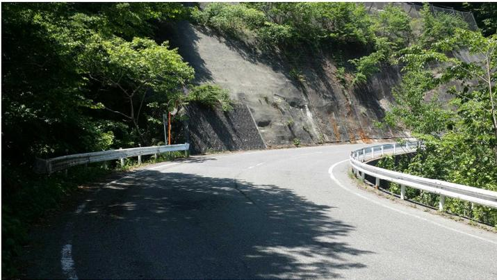
写真1 赤山沢に架かっている最上流の橋。手前左側から沢に入れる。なを、道路前方のコンクリート擁壁が、排水で茶色に着色している。奥に、金属鉱物岩がある証拠である。あつた坑口をコンクリートで埋めたのであろうか？ 廃鉱山で偶にある処理である。
