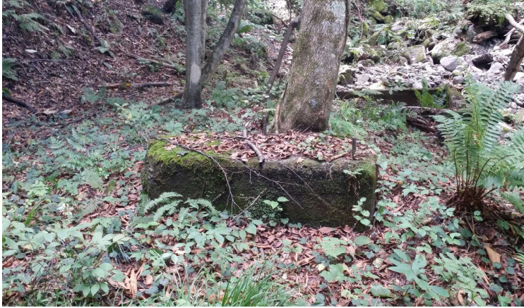
写真 1 4 写真 1 3 で示したコンクリート残骸の上にあったボルト付きコンクリート台。廃鉱山によくある。隣にある木の太さに時間の流れを感じる。
