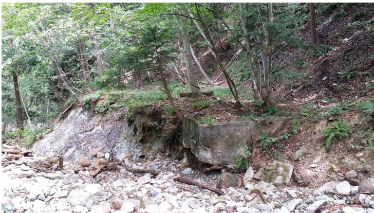
写真13 澤田坑跡と思われる箇所にあった、コンクリート基台の残骸。その箇所にはボルト付きのコンクリート台もあった。写真14参照。このコンクリートのある斜面に「滝田坑」跡があるはずなのだが、見つけれなかった。沢の対岸には広い平坦部があった。本論の図4からすると、この平坦部に鉱山施設があったはずである。平坦部の沢側部分は広いズリ跡である。
