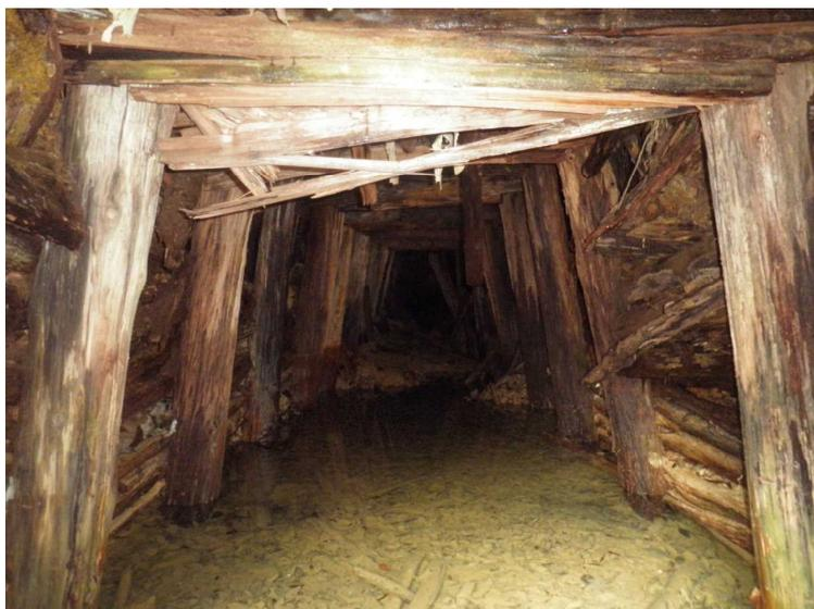
写真8 写真7に示している坑口に近寄った。その内部の様子。入口部に土砂が堆積して、排水が滞っていた。
