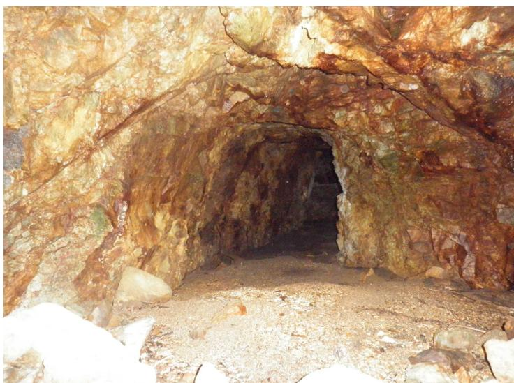
写真10 写真9で示している坑口の内部の様子。こちらの坑道は支柱もなく、非常にしっかりしている。坑壁は鉱染状岩石のようである。
