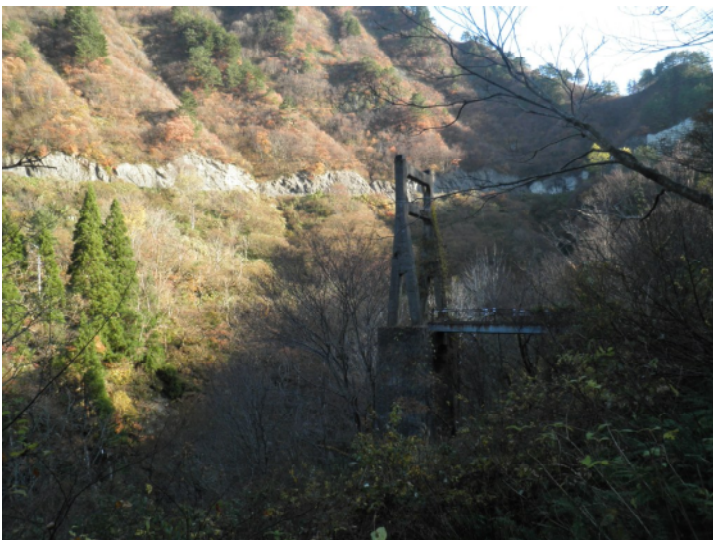
写真2 A点の位置である。加治川を跨いで架けられていた吊り橋の橋脚跡である。中央上を左右に伸びているのは加治川ダムへの道路の側壁である。
