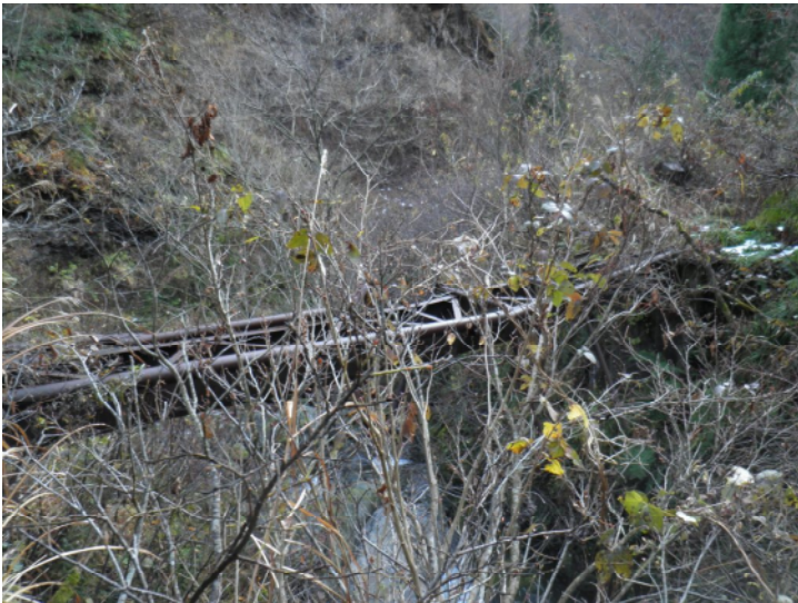
写真5 カマボコ型トンネルの先にあった、朽ちた鉄橋。下を流れている沢は籠久保沢。C点である。籠久保沢は左岸を登って行ける。
