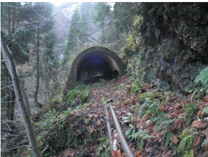
写真3 B点の位置である。周りには各種の施設・材料が転がっている。左下が簀立沢。トンネルは人の背丈ほどである。内部にはレールが残っており、途中で山側に分岐し、完全に土砂に埋まっている。埋もれたレールの先には坑道があったはずである。
