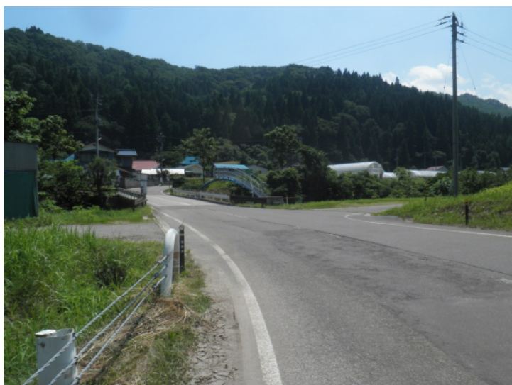
写真1 400号を南下してくる。道路は大きく左折し、先に橋が見える。が、手前の右側の村道に入っていく。
